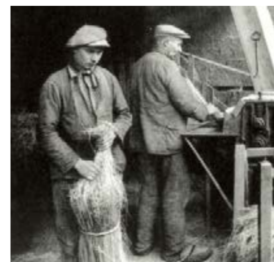
Machinaal brakelen van geroot vlas, 1930, Provincie West-Vlaanderen. (bron: Centrum Agrarische Geschiedenis)
