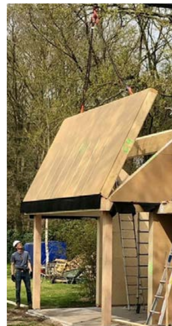
Prefab bouwen met stropanelen (bron: Strobouw.nl)
