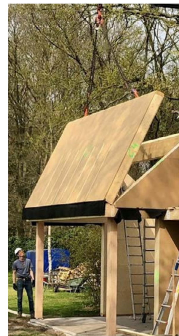
Prefab bouwen met stropanelen (bron: Strobouw.nl)
