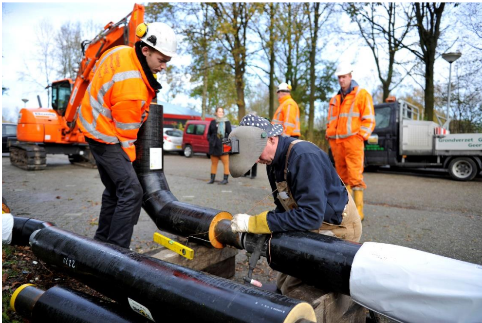
Afbeelding 2: aanleg van een warmtenet in Hoogezand in 2015.
