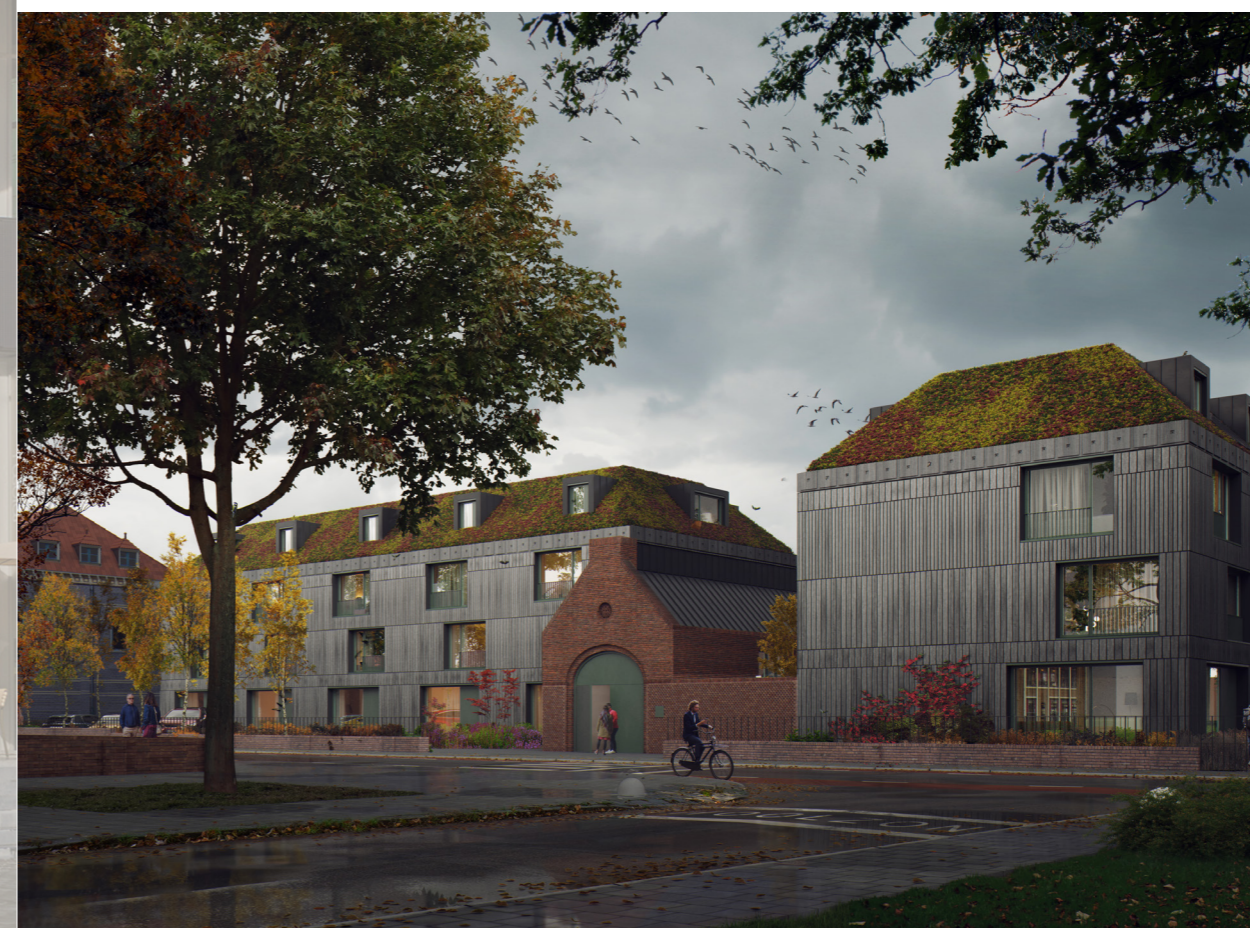
Afb. 11 Circul Amsterdam: Gelamineerd lariks t.b.v. de houtconstructies. ©John Lewis Marshall
